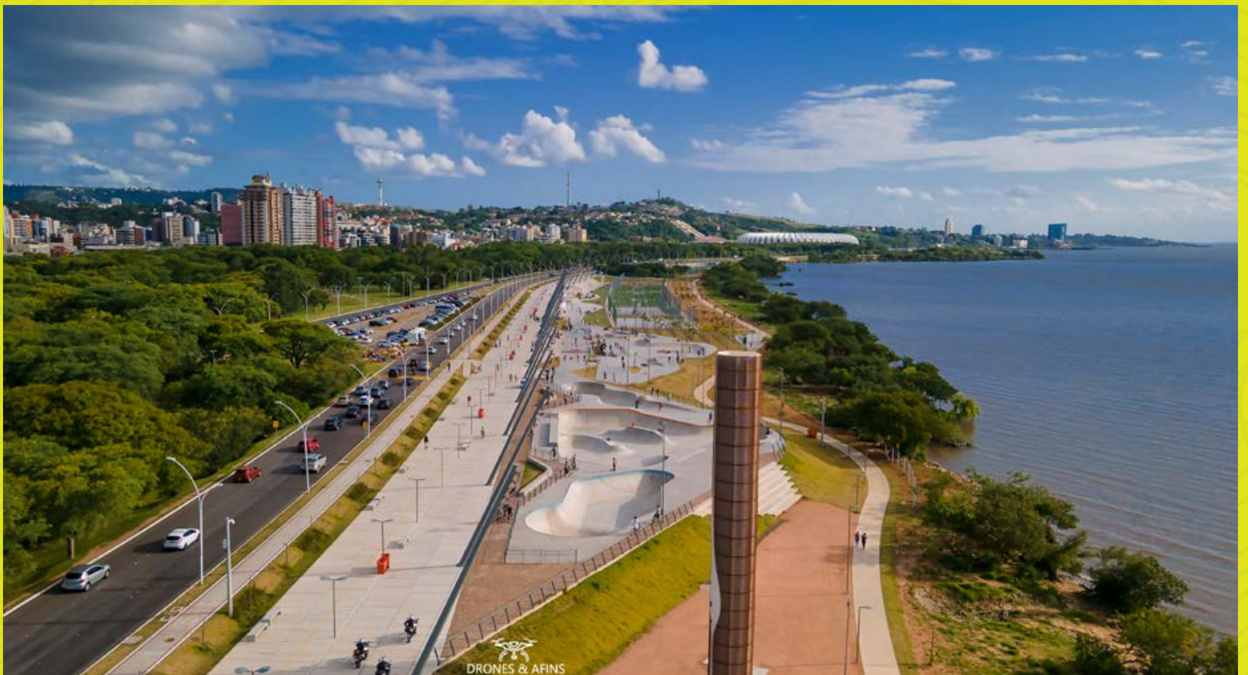
Obra da Orla do Guaíba Trecho 1 – Porto Alegre, RS
